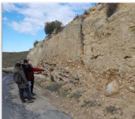
El destruido talud de la carretera de Huerta a Cabañas de Yepes.
