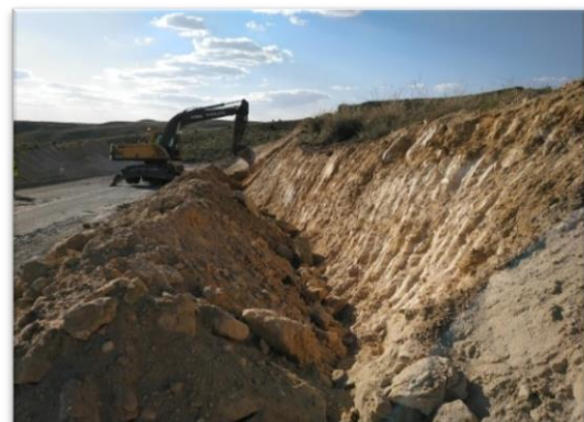
Trabajos de verticalización del talud.
